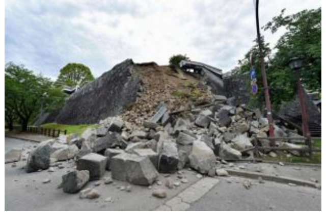
熊本地震で崩れ落ちた熊本城の石垣＝2016年4月16日、熊本市中央区【時事通信社】
