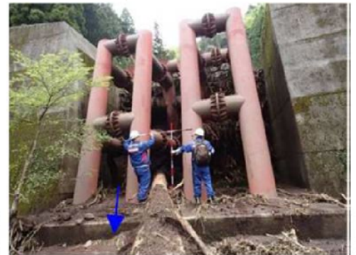
砂防堰堤下流側より
